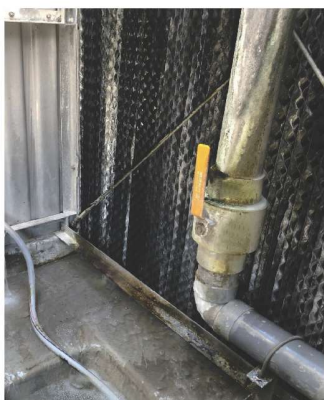
設備安裝前(使用化學藥劑處理)
